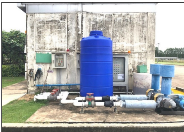
ภาพที่ 2.12 ถังเอนไซม์ เพื่อย่อยไขมันในระบบบำบัดและปั๊มเติมอากาศ
