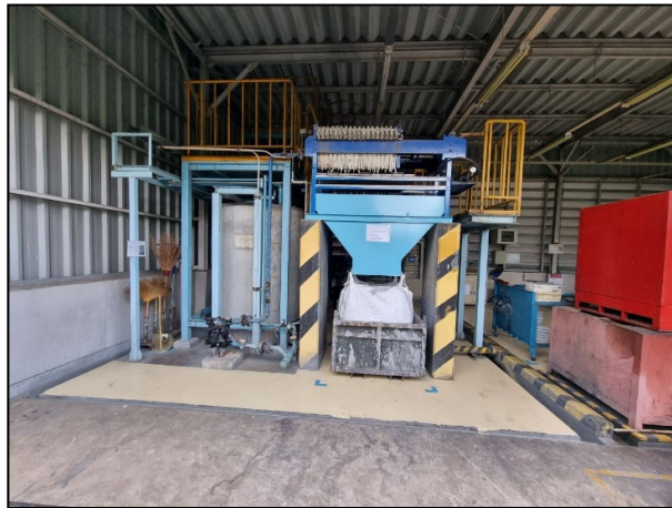
ภาพที่ 2.14 ระบบบำบัดน้ำเสียแบบตกตะกอนทางเคมี
