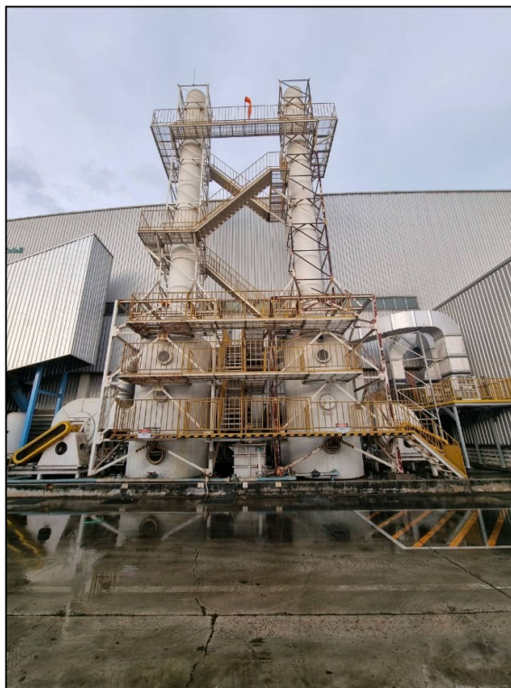
ภาพที่ 2.2 ระบบบำบัดมลพิษทางอากาศ (ระบบดักฝุ่นเปียก Wet Scrubber)
