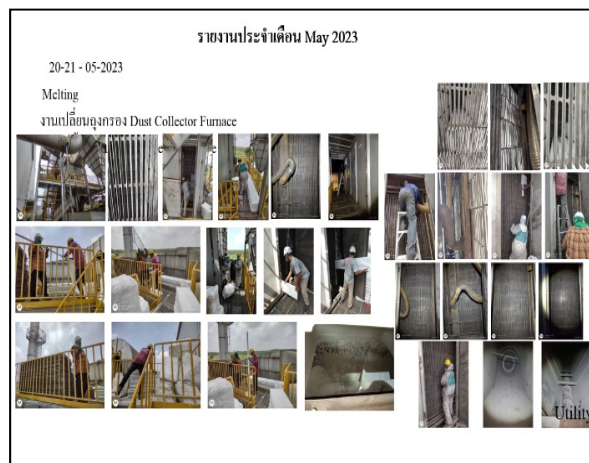
ภาพที่ 2.6 เปลี่ยนถุงกรองของระบบ Bag filter
