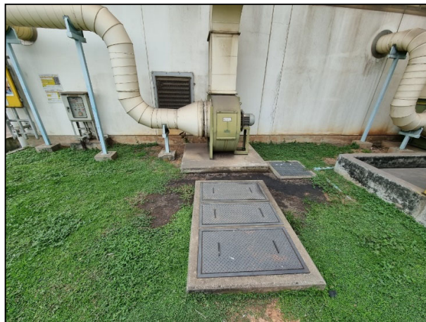
ภาพที่ 2.15 การระบายน้ำทิ้งจากระบบ Air Compressor
